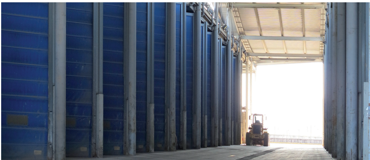
Figura 9.7 - L'interno del capannone di pre-stoccaggio
