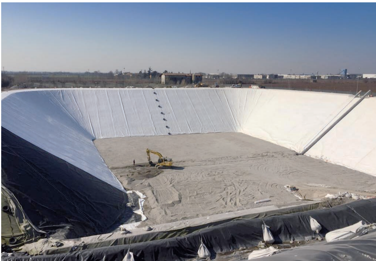
Figura 9.3 - Lotto 8 in fase di realizzazione
