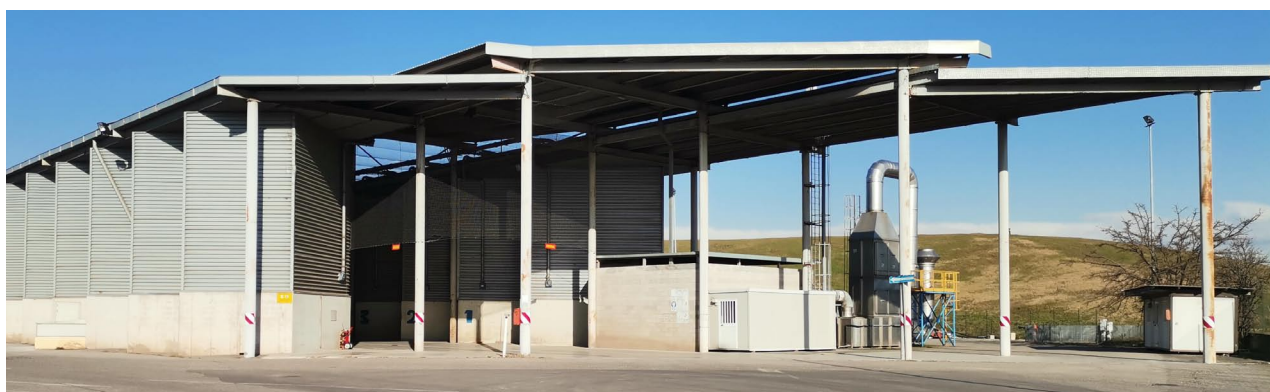
Figura 9.2 - Capannone di pre-stoccaggio
