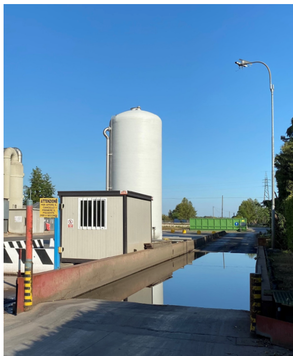
Figura 9-9 - Impianto di raccolta acque meteoriche piazzale Ovest e vasca lavaggio ruote
