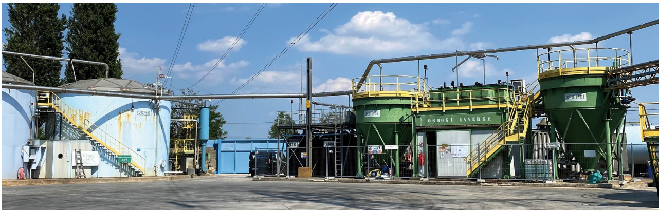
Figura 9-5 – Osmosi inversa e vasche di monitoraggio CFB
