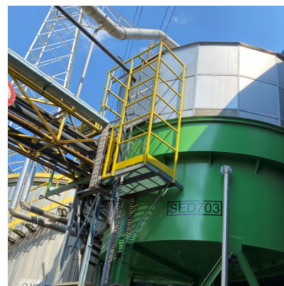
Figura 9-4 – Impianto chimico-fisico biologico – sedimentatore SED703
