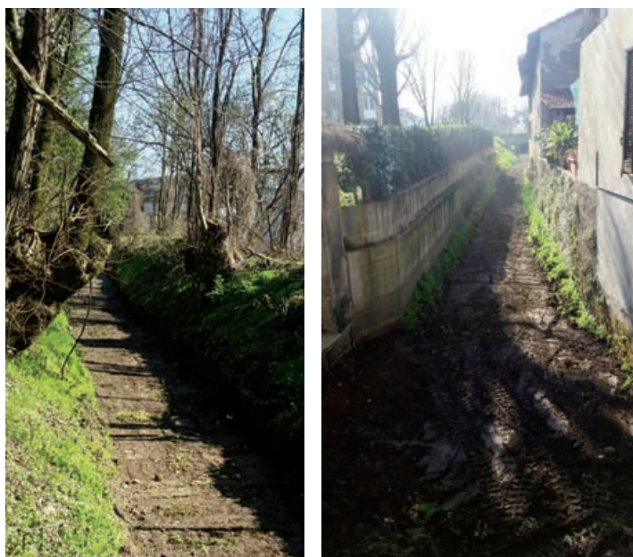
Figura 9-6 – Scorci della Roggia Crosina con il greto in asciutta, in occasione dell'ultima pulizia
