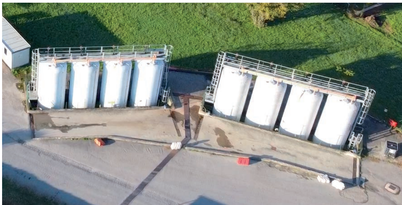
Figura 9-4 – Parte dei serbatoi di stoccaggio del percolato, a servizio del lotto C
